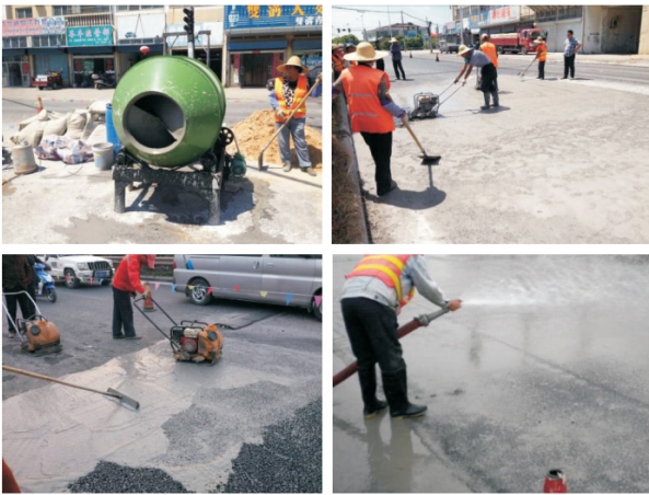
图1 灌入材料施工现场
