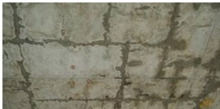
图1 温度裂缝
