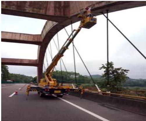
图2 机械设备检测公路
