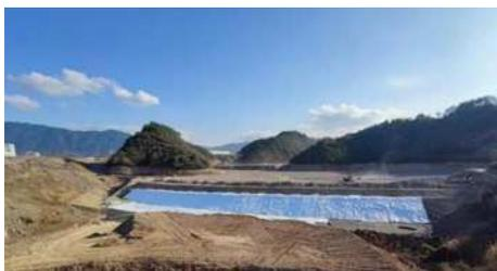
(2)土工格栅。土工格栅采用外覆聚乙烯护套保护层形成的条带式格栅通过超声波焊接工艺相互连接形成网状平面结构的格栅。用于本项目1:1.5高填方边坡的土工格栅是经过特殊工艺制造而成定制化材料,具有更高的抗施工损伤能力及耐久性。高边坡内铺设土工格栅,确保边坡稳定,防止不均匀沉降适合用征地范围不够的项目。通过土工格栅的铺设,回填料的碾压,使边坡整体稳定得到提高,具有减少填料的特点。
