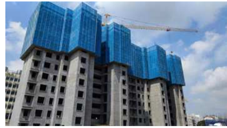
作业面防护板
