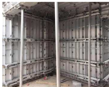
墙柱安装完成图
