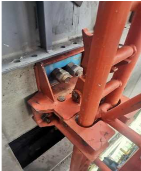
导向座安装示意图
