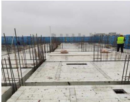
顶板拼装完成图
