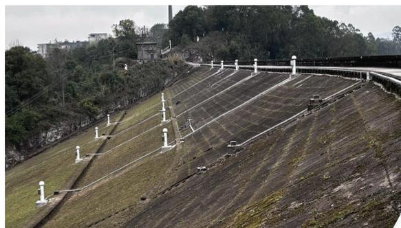
二是大坝渗流监测系统智能化升级改造。开展渗流压力监测、绕坝渗流监测、渗流量监测监控布网的研究与应用。根据大洪河水电站主坝、厂房和左岸溢洪道、右岸溢洪道59个渗流测点，建立了渗流监测模型，开展监测监控布网的研究与应用。大洪河水电站大坝渗流监测系统，含渗流压力监测、绕坝渗流监测、渗流量监测项目。相比主坝，六座副坝的坝高均低于15m，且主副坝均为土坝。结合大洪河水电站大坝的实际规模，对主坝及左右岸溢洪道现有人工测点44个渗流监测，全部进行渗流压力、绕坝渗流、渗流量监测自动化改造和自动化监测布网。
