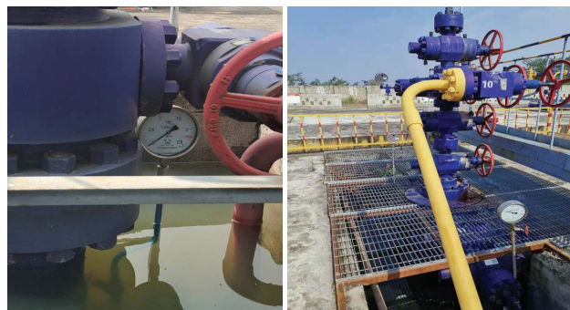
安装引压装置后图片
