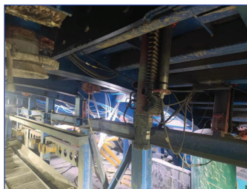
图 2.3 拱顶插入式振捣器振捣图
