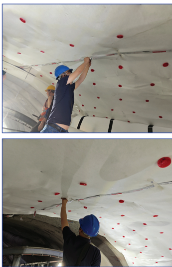
图 2.1-1 分布式压力传感器安装图
