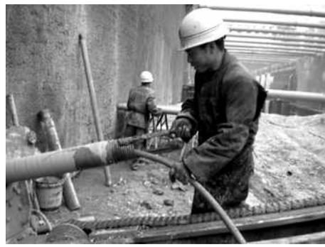
锚索安装到位后, 即进行全孔一次性注浆。灌浆管设置 2 根  $\phi 20$ mm PVC 管作为进、出浆管。注浆采用水灰比为 0.38~0.45 水泥砂浆, 强度不低于设计值 M30, 注浆压力为 0.5MPa, 为确保施工安全, 不影响开挖施工进度, 在浆液中掺入适量对锚索无害的早强剂, 实施前先进行试验验证。砂浆在初凝前用完, 并严防石块、杂物掉入浆液, 孔口溢出浆液或排气管停止排气时, 可停止注浆。注浆时宜适当加强注浆压力, 使浆体饱满, 并与地层密贴。
