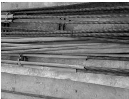
(4) 锚索入孔前重新对钻孔进行检查, 并将孔内沉渣清理干净。锚索入孔时用力要均匀一致, 不得转动锚索体, 随时检查隔离架及绑扎丝, 发现有移动、损坏、脱落等要及时处理, 必要时更换重新编制。
