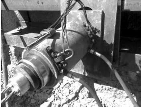
按设计要求,当锚固体强度达到设计强度值的80%即24Mpa,并且混凝土腰梁的承载强度达到80%以上时,方可进行张拉施工。根据不同的锚固荷载,分别采用YCW-250型和YCW-400B型千斤顶配合ZB4-500型高压电动油泵整体张拉。张拉设计轴力及锁定荷载见表4.1。
