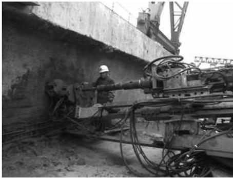
(2) 钻机钻进前在孔口埋设 2 米长  $\Phi 200$  钢套筒, 钢套筒按照锚索打设角度设置。开孔时应严格控制钻具的倾角及方位角, 当钻进 20cm—30cm 后应校核角度, 在钻进中及时测量孔斜并及时纠偏, 锚索水平方向孔距误差不应大于 0.05m, 垂直方向孔距误差不应大于 0.1m; 钻孔底部偏斜误差不应大于  $1^\circ$ , 孔深不应小于设计长度。钻孔测斜采用 CX1 型钻孔型测斜仪, 钻孔结束后将孔内残留的废渣和积水冲洗干净。
