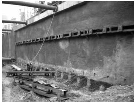
钢围檩安装前, 以 C20 细石混凝土填平桩间凹槽, 保证钢围檩与围护桩密切接触。按设计施工图的布置间距, 在围护桩结构上定出支撑中心点位, 以中心的水平线为基准, 准确画出支撑牛腿的位置, 定出螺栓点位, 在螺栓点位上使用手持电钻在围护桩上钻眼, 打入膨胀螺栓。安装三角托架及斜拉筋上部固定角钢, 紧靠桩身吊装钢围檩, 放置在三角架上, 最后安装斜拉筋并拉紧。
