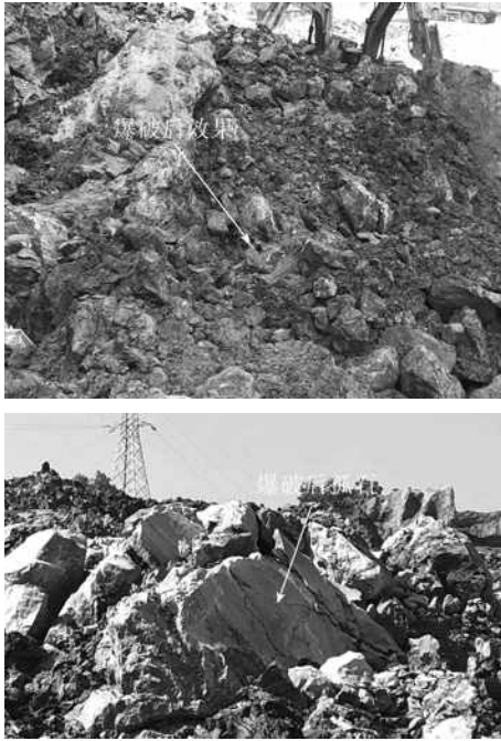
图6 爆破后效果
