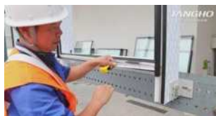
图5 玻璃托板安装
