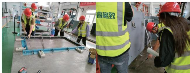
图4 学生进行叠合板制作实训 图5 学生进行剪力墙吊装实训
