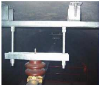
图2 刚性接触网垂直悬挂示意图
