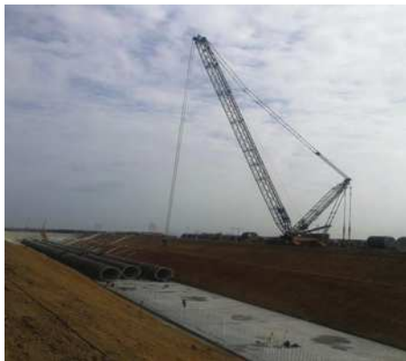
图5-1 坡高15m处650t履带吊安装作业时边坡状况图
