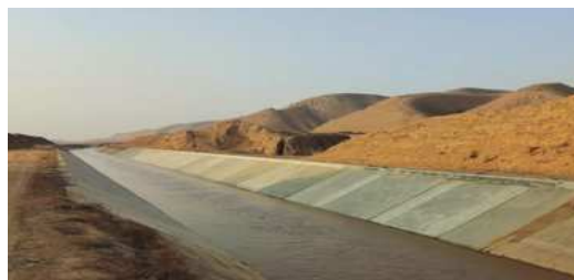
固海扩灌扬水更新改造工程渠道高边坡
