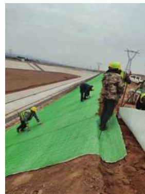
生态植被网垫护坡应用于高边坡治理
