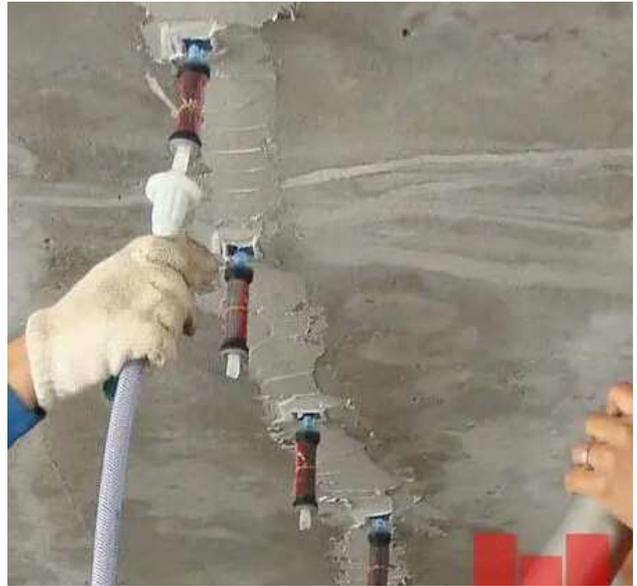
图1 混凝土裂缝灌浆修补施工图
