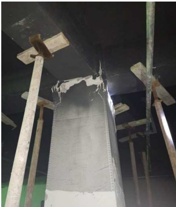
图2 混凝土置换施工效果
