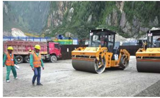
图2 某大坝混凝土碾压
