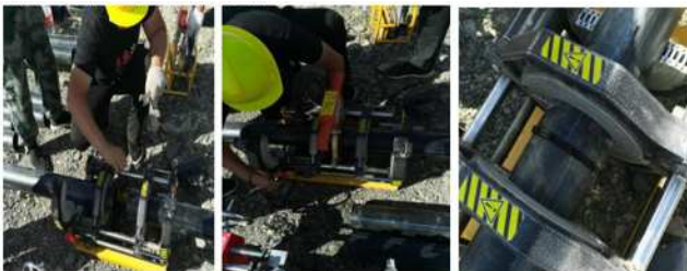
铁端面 热熔 热熔翻边
