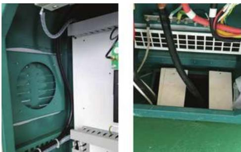
(a) 散热窗敞开 (b) 电缆口未封堵
