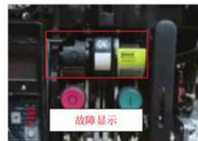
原因分析:对断路器进行拆解后发现,内部固定状态反馈板的软连接断裂使反馈板松脱,反馈板上辅助触点与断路器本身机械传动部件卡死,导致该连杆不能回到正常位置,该机械结构连杆与断路器显示面板的OK指示连接,从而影响后续机械连锁致使无法进行合闸操作。
