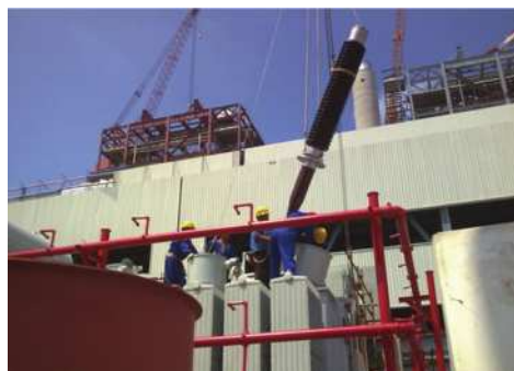
图1 变压器安装
