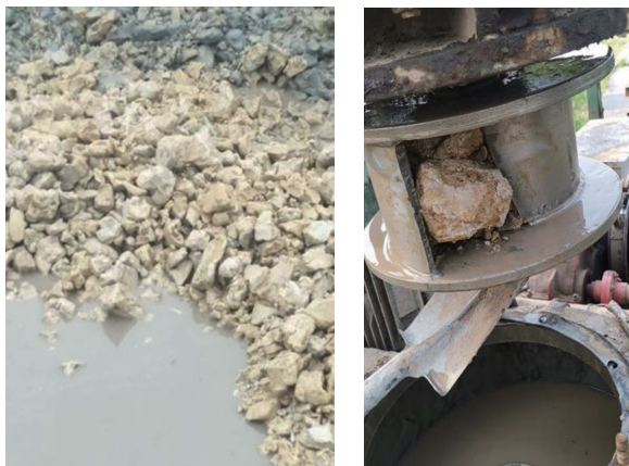
图 4.1 现场吸出大量砂礓、钻头卡死
