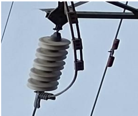
这也就是长针引雷器的工作原理,加上线路铁塔上侧避雷
