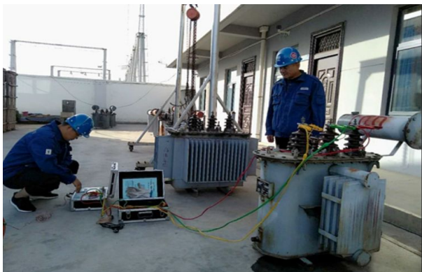
图4 变压器现场维修图
