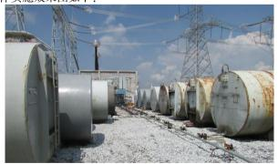
在施工中我们进行了跟踪检查,经过全封闭系统滤油的油源经过颗粒度试验,一次合格率达到100%,且全封闭式滤油系统加工难度相对较低,成本低廉,制作时间短,操作简便。并且还能够在保证特高压变压器油颗粒度合格的大前提下,大幅度提高滤油效率,缩短工期,经拆卸之后仍可再次利用,达到了预期的效果。
