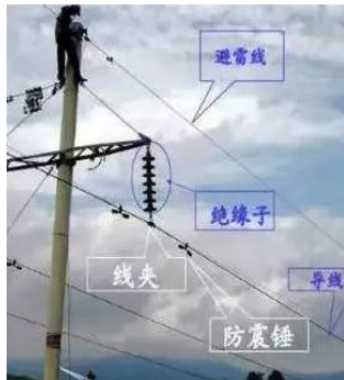
图 1 磁性绝缘子
