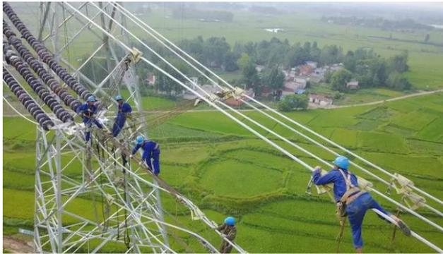
图1 架线施工
