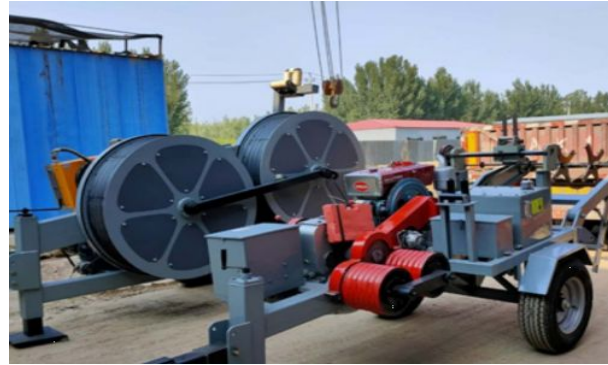
图 1 牵引场布置现场
