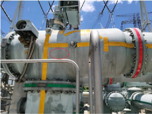
图 1 50522 隔离开关 A 相气室超声波局放异常位置
