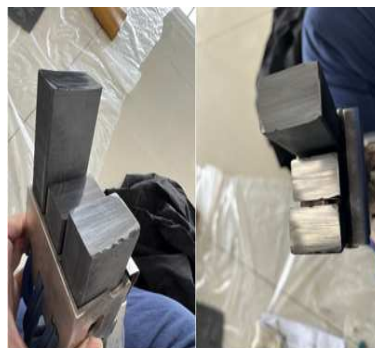
图4 发电机碳刷崩角现象
