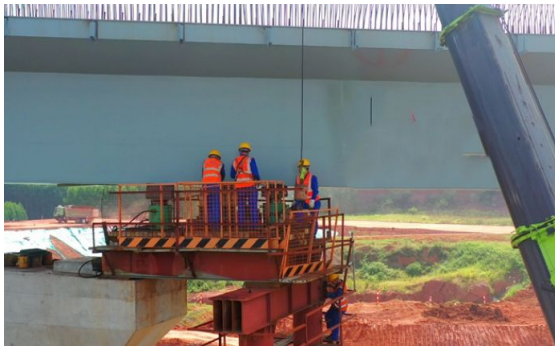
图 1 安全施工平台
