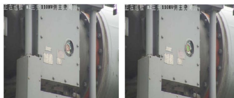
图 4 闸刀识别：(a) 巡视拍摄图；(b) 识别结果
