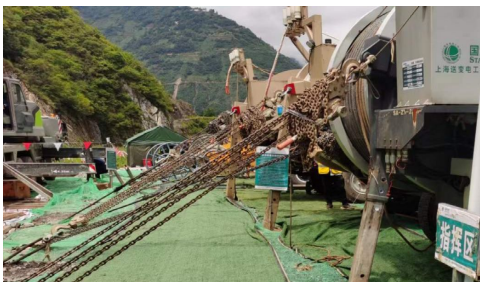
图 1 张力放线施工中的地锚应用场景
