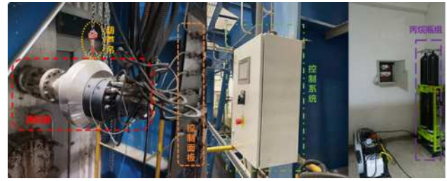
图 3 强力波清灰系统现场安装图
