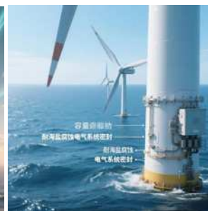
图3 电气系统可密封部位 (海上箱变处)
