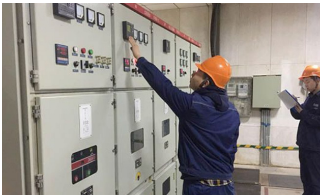
图 2 继电保护装置定期检查
