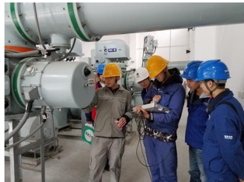
图 21 加强人员参与 110kV 变电站及智能变电站检修
