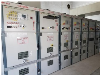
图 19 大修技改更换设备
