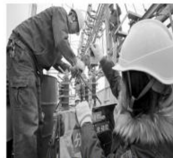
图 1 更换故障开关
