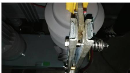
图 1 电斥力作用下隔离退刀
