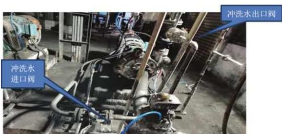
图4 石灰浆泵反冲洗
