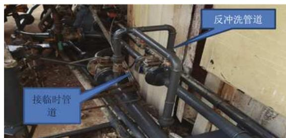
图5 石灰浆进浆反冲洗及临时管道接口
