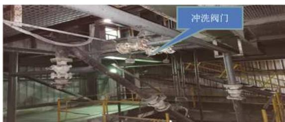
图3 石灰浆制备罐到计量罐反冲洗
