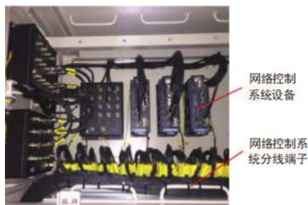
图2 网络控制系统端子排
