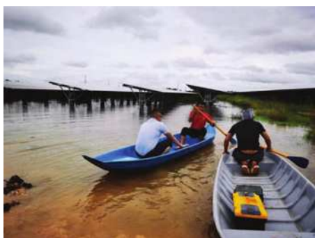
图1 越南某处光伏项目运行环境
