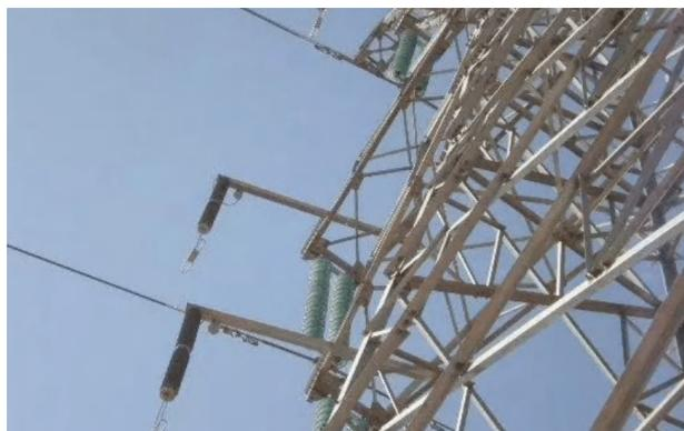
图 1 输电线路避雷器
