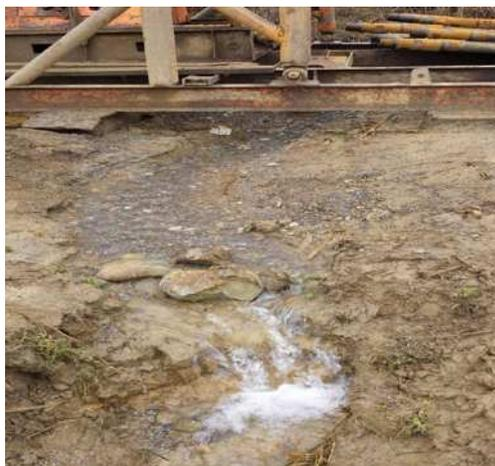
SK3 孔钻进施工结束后地下水自流
