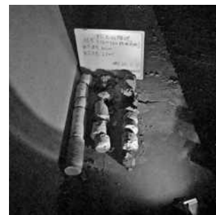
照片2-4 K54+350路面右侧
