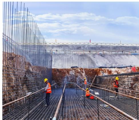
图4 冷却水管安装
