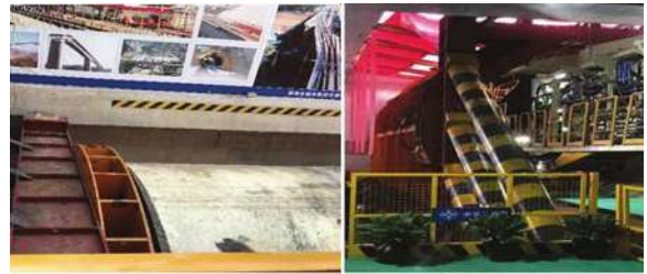
图3-3 安装反力架、钢套筒尾部环梁
