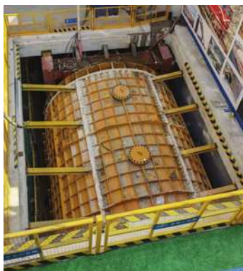
图2-2 密闭钢套筒始发装置整体实景图
