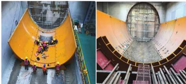
图3-1 钢套筒下部组装
