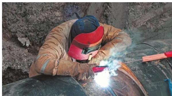
图2 供热管道焊接现场施工图
