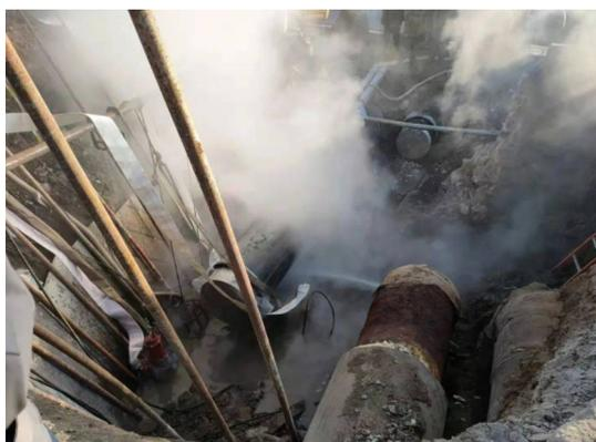
图1 供热管道泄漏图
