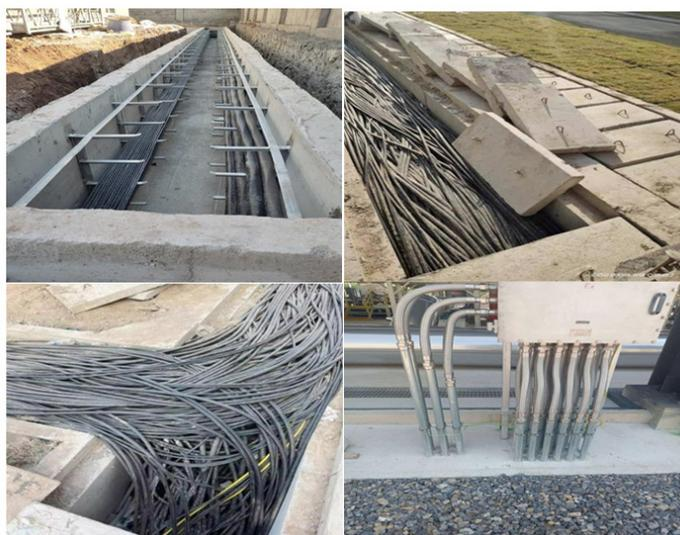
图1 防爆电气布线施工图
